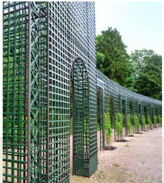
Gebetsgänge der Gartenmoschee und Laubengänge im Schlosspark Schwetzingen Anstrichaufbau: Grundiert mit JOTUN TREGRUNNING KLAR, zweimaliger Anstrich mit DRYGOLIN VINDU OG DØR
